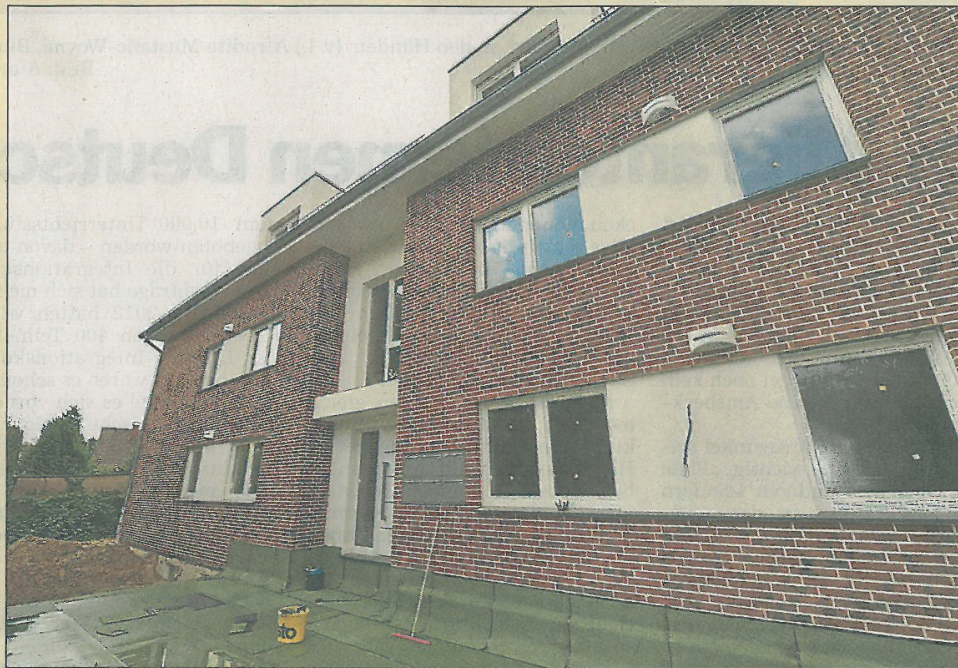
Der Eingangsbereich des Hauses Berliner Straße 162 führt vor Augen, dass sich die Arbeiten bereits in einem fortgeschrittenen Stadium befinden. Bilder: Dünhölter
